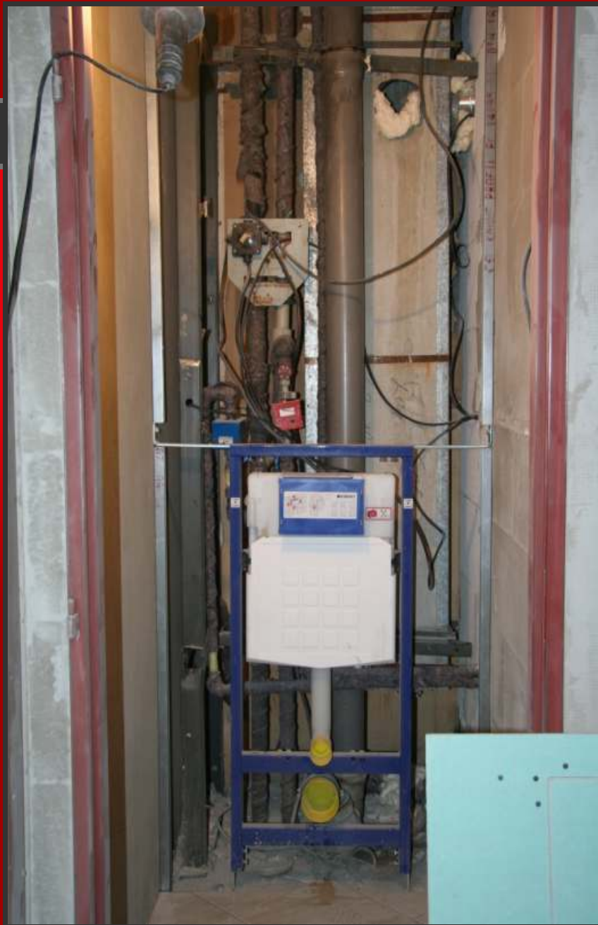
Pohled na instalační šachtu s osazeným systémem závěsného WC.
